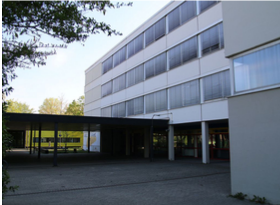
Eingangsbereich der Schule (2016, FL)
