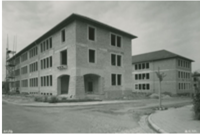
Gebrüder-Grimm-Schule (hinten) im Rohbau (1950, StadtA HN)
