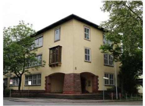
Das Schulgebäude an der Gartenstraße (Mai 2014, HMS)
