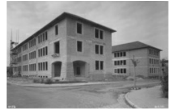
Rohbau (1950, StadtA HN)
