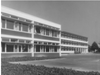
Schulgebäude (1963, StadtA HN, Stadtplanungsamt)
