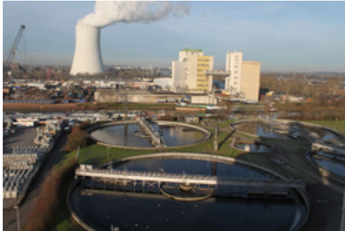
Kläranlage Heilbronn (Feb. 2014, BK)
