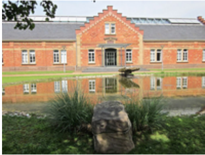
Das Alte Wasserwerk (Jun. 2011, RSch)
