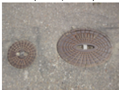
Unterflurhydrant (2011, RSch)
